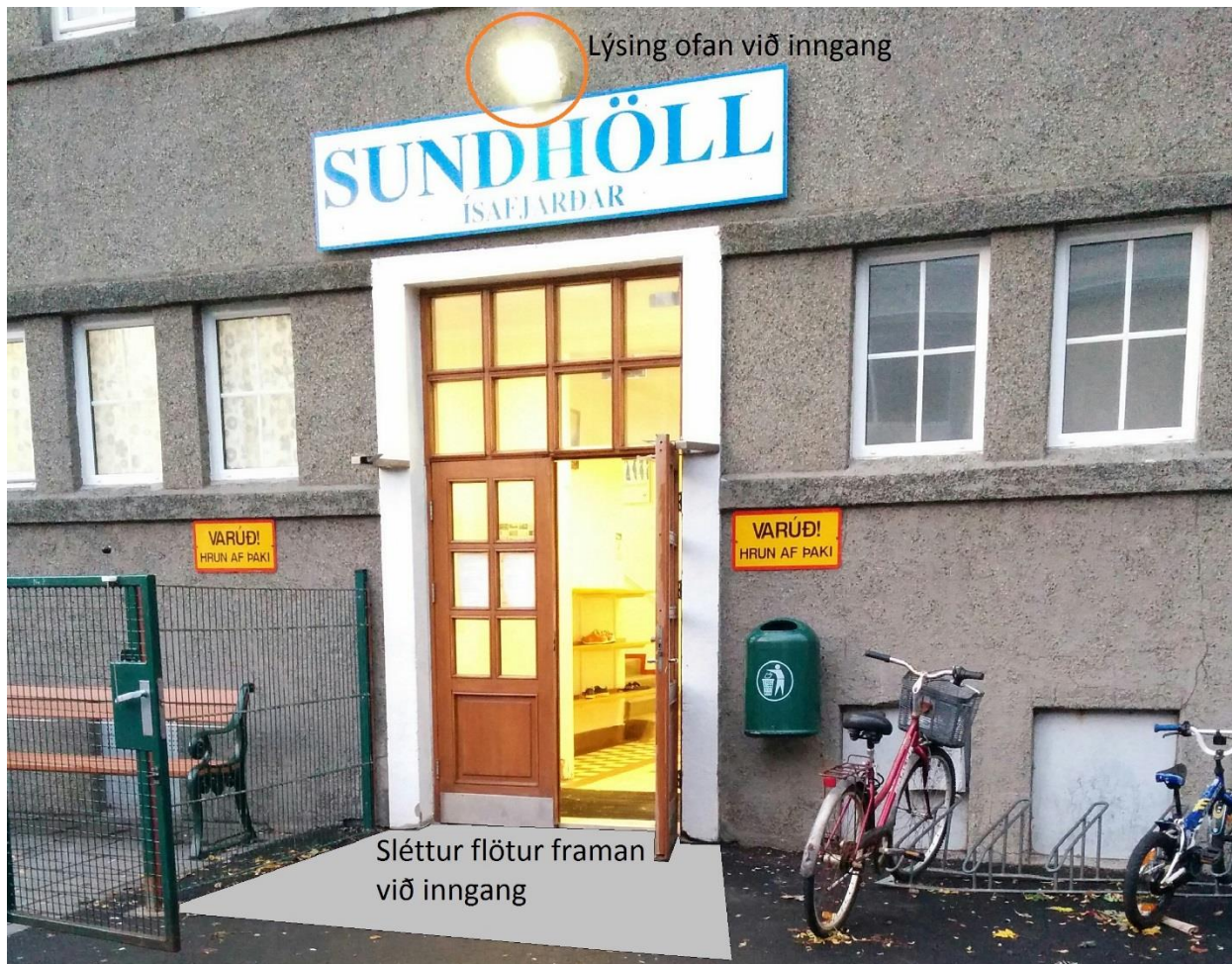
Mynd 5-5: Myndin sýnir inngang í sundlaugina og flöt sem má hækka til að auðvelda aðgengi, svæðið yrði með halla 1:50. Dýraopnari yrði staðsettur á staur um 1m frá inngangi
