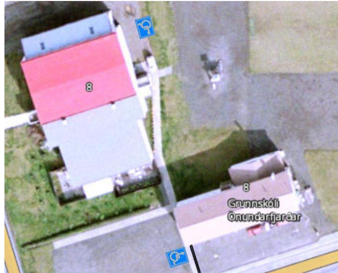
Mynd 3-1: Myndin sýnir Grúnskóla Flateyrar (Önunarfjarðar) og íþróttamiðstöð. Á myndinni má sjá hvar staðsetja mætti sérmerkt bílastæði fyrir grúnskólann annars vegar og íþróttamiðstöðina hins vegar. Á myndinni er einnig sýnt hvernig setja megi leiðarlínur til að leiðbeina blindum og sjónskertum að grúnskóla og íþróttamiðstöð.
