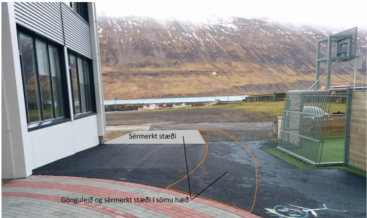
Mynd 4-1: Myndin sýnir aðkomu að grunnskóla Suðureyrar. Æskilegt væri að malbika malarsvæði þar sem sérmerkt bílastæði á að koma og einnig almennu bílastæðin. Sérmerkt bílastæði og aðliggjandi stígur er hækkað upp svo að halli sé lítill.
