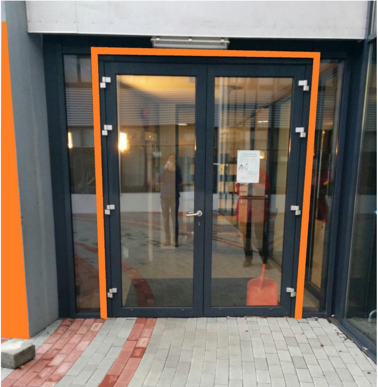
Mynd 4-3: Inngangur að Sundlaug Suðureyrar. Myndin sýnir hvernig litamunur á hurðarkörmum og „ramma“ í kringum innganginn gerir hann sýnilegri.
