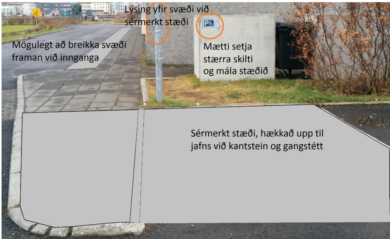
Mynd 5-8: Myndin sýnir aðkomu að leikskólanum Sólborg á Ísafirði. Sérmerkt bílastæði er hækkað upp og merkt betur. Mögulega er hægt að breikka svæði við innganga og færa skammtíma bílastæðin.
