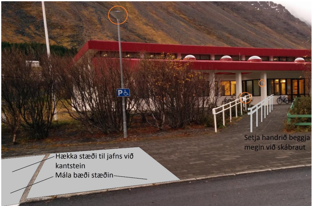
Mynd 5-10: Myndin sýnir aðkomu að íþróttamiðstöðinni Torfnæs á Ísafirði. Hækka þarf annað sérmerkt bílastæðið og merkja þau betur. Einnig þarf að setja handrið beggja vegna skábrautar, sem og bæta lýsingu frá bílastæði að inngangi.
