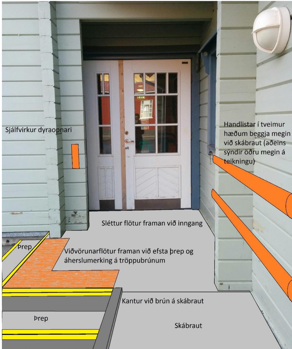
Mynd 3-6: Myndin sýnir inngang að leikskólanum á Flateyri. Nokkuð þröngt svæði er við innganginn og því þarf að setja pall fyrir framan innganginn og út frá honum skábraut og þrep. Einnig þarf að setja handrið með tveimur handlistum við skábraut, viðvörunarfleti við þrep, mála neðsta þrep og staðsetja sjálfvirkann dýraopnara fyrir framan innganginn.
