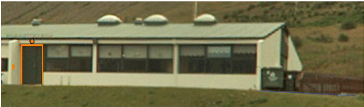
Mynd 2-7: Myndin sýnir leikskólann á Þingeyri, staðsetningu á sjálfvirkum dýraopnara, hvernig mála megi dyrakarma svo að inngangur verði sýnilegri og hvernig bæta megi lýsingu. Hægra megin á mynd sést svæði þar sem skýrsluhöfundar leggja til staðsetningu fyrir nýtt sérmerkt bílastæði (blá lína).
