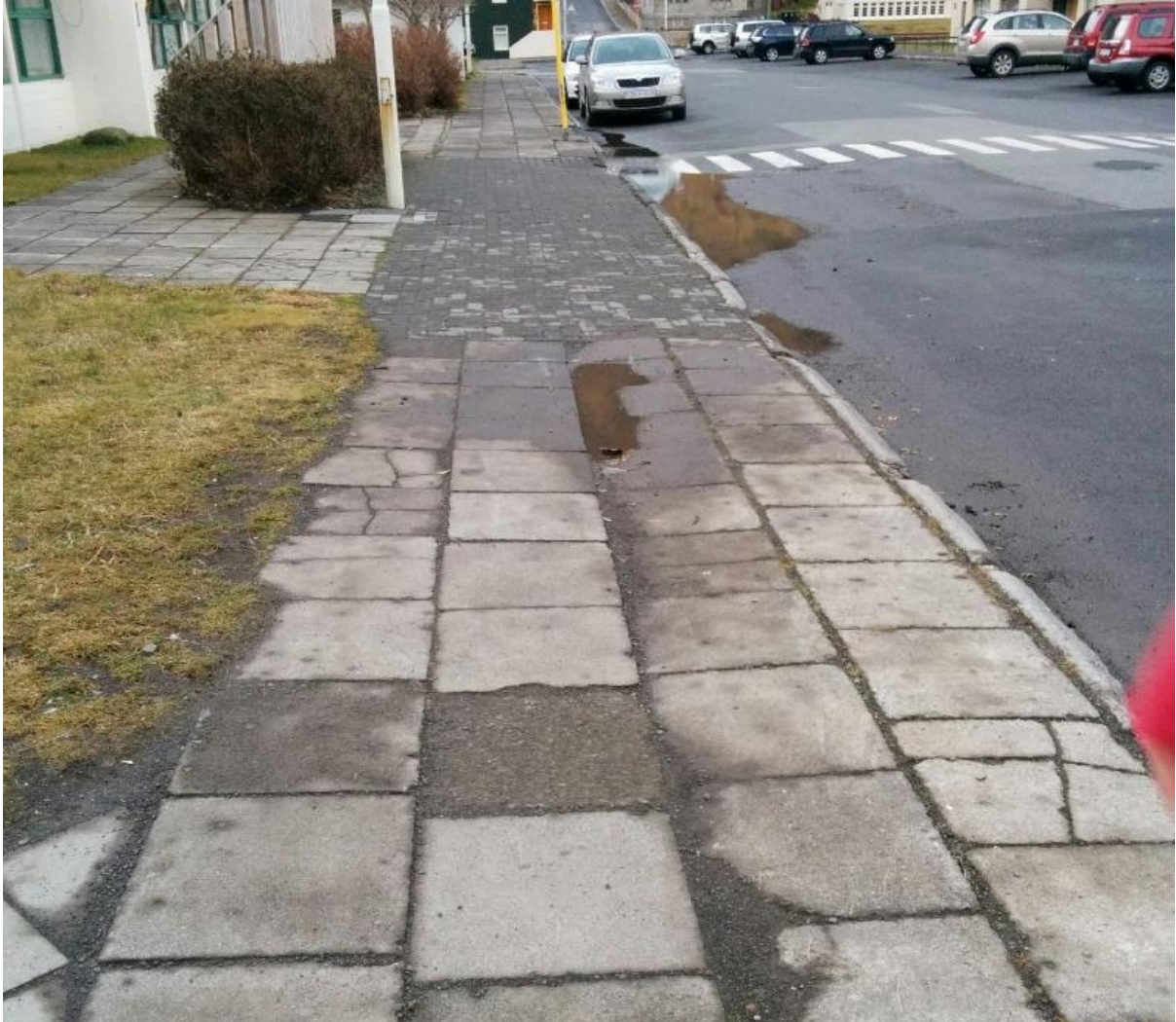
Mynd 5-6: Göngustígur fyrir framan leikskólann er í slæmu ásigkomulagi. Einnig má sjá núverandi göngupverun.
