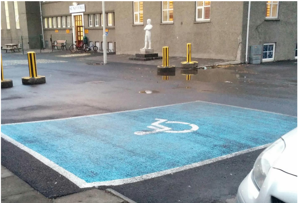
Mynd 5-1: Sérmerkt bílastæði við grunnskóla. Einnig má greina sérmerkt bílastæði við sundlaug (blátt skilti), það þarf að merkja betur
