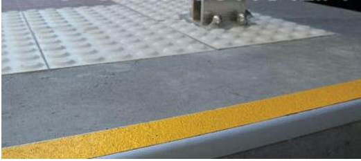
Mynd 1-6: Viðvörðunarfletir við efstu tröppu
