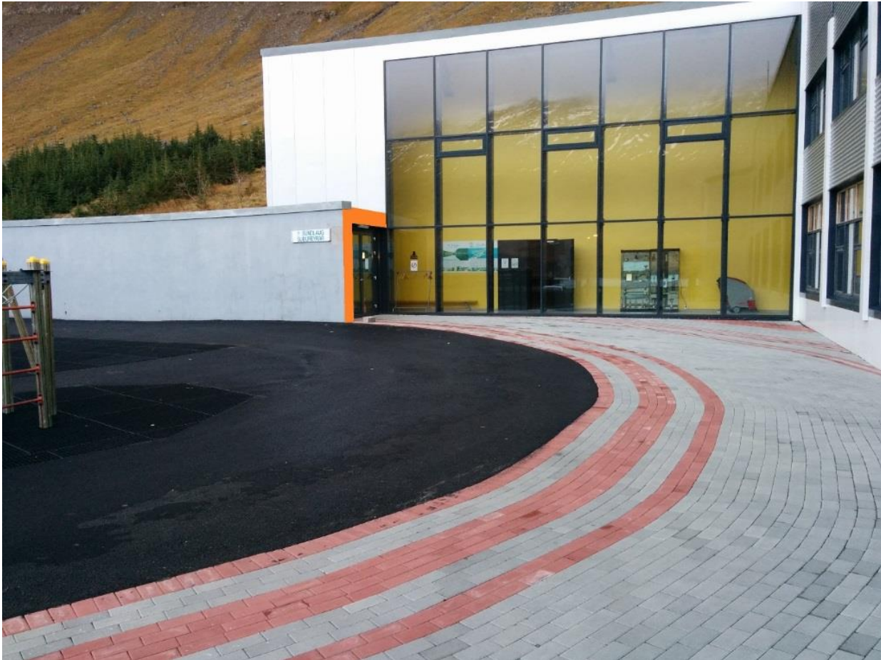
Mynd 4-4: Inngangur að sundlaug Suðureyrar. Myndin sýnir hvernig litamunur á ramma í kringum innganginn gerir hann sýnilegri. Möguleiki er á að staðsetja sjálfvirkan dyraopnara á staur um 1m frá innganginum. Hér má einnig sjá hvernig leiðarlínur vísa veginn að inngangi.
