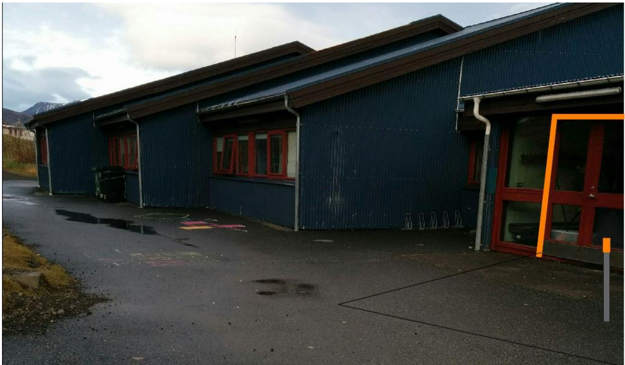
Mynd 2-9: Myndin sýnir suðuringang að grunnskóla Þingeyrar. Svæði fyrir framan inngang er hækkað upp, dyrakarmar málaðir og sjálfvirkur dyraopnari er staðsettur á staur um 1m frá inngangi
