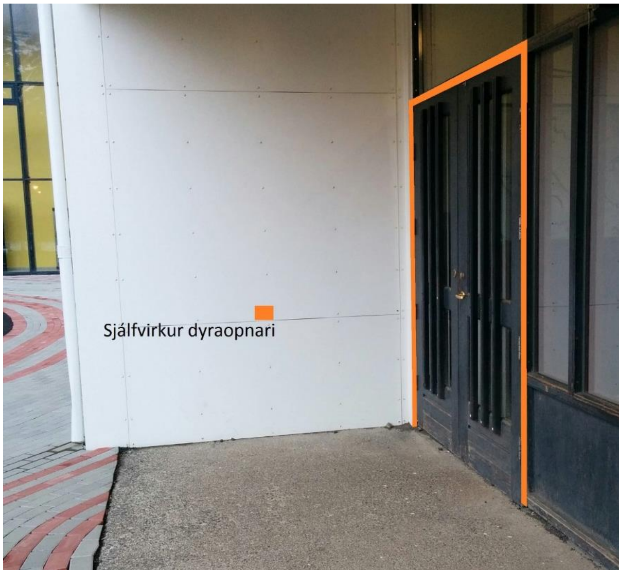
Mynd 4-2: Inngangur við grunnskólann á Suðureyri. Myndin sýnir mögulega staðsetningu á sjálfvirkum dýraopnara og hvernig inngangur sker sig betur úr með nýrri málningu á hurðarkörmum.
